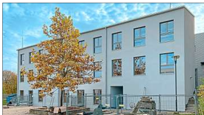
Bei dem fertigen Gebäude fehlen nur noch die Außenanlagen. Errichtet wurde es an der Rückseite des Hallenbads.
