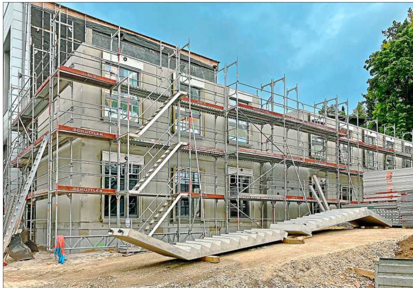
Während der Bauphase erkennt man noch deutlich die einzelnen Module, bei denen zum Beispiel Fenster und Sonnenschutz schon eingebaut sind. Vor dem Gebäude liegen die Fertigtreppe, die später verbaut wurden.
